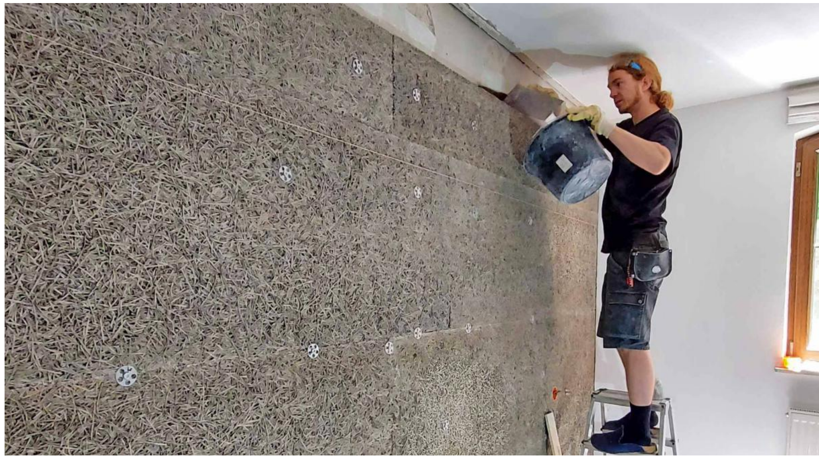
Wände aus den natürlichen Rohstoffen Hanf, Kalk und Wasser sind wärmedämmend und lassen sich am Ende ihres Lebenszyklus wiederverwerten. FOTO: PAULY
